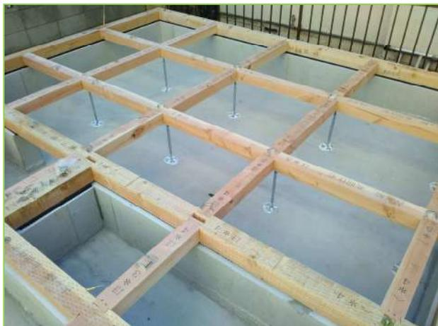
床補強(大引き・鋼製束取付)
